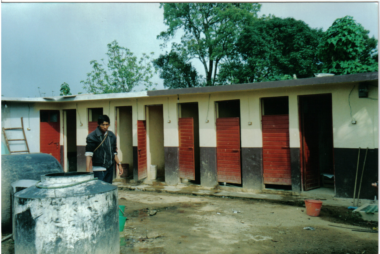
Construcció d'uns banys públics a San Andrés Sacamch'en de los Pobres
