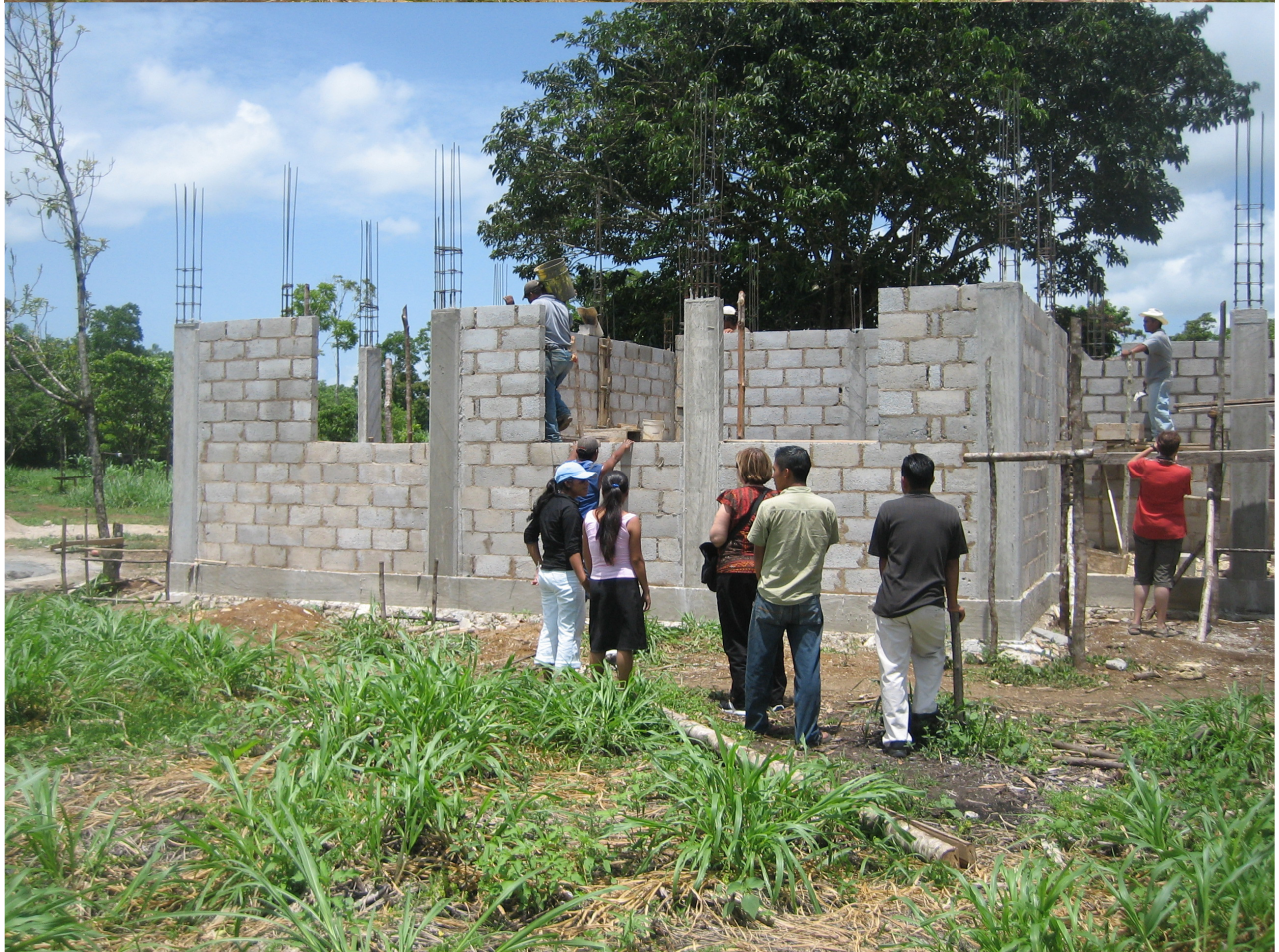
Construcció de la Clínica Regional del MAREZ el Trabajo, anomenada Ixchel.
