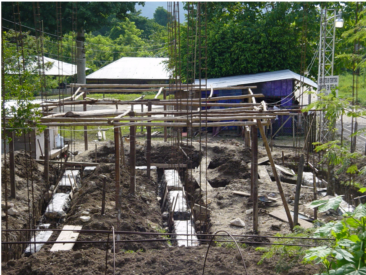
Construcció casa Junta de Buen Gobierno “Nueva Semilla que va a producir”
