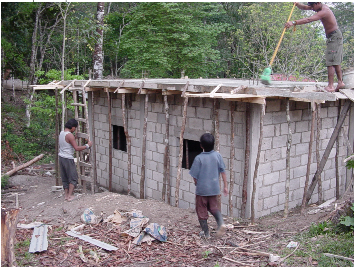
Construcció de la cabina per l'emissora de ràdio autònoma.
